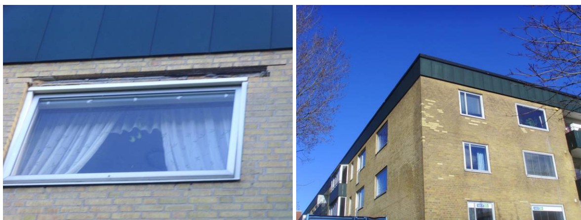
Figur 2 t v – ny balk monteras ovan fönster. T h – vissa tegelstenar har utsatts för frostsprängning och byts ut
